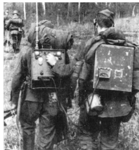
Рис. 7. Носимая УКВ-радиостанция Torn.Fu.d2
